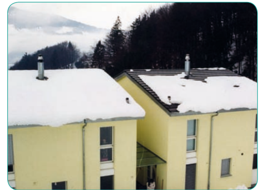
Linkes Dach: Dämmung mit unserem Zellulosedämmstoff
