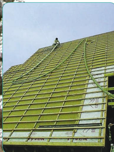
Dämmschüttung - die „einfache“ Dämmvariante
