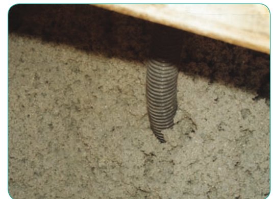
Aufblastechnik - die „professionelle“ Dämmung
