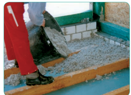
Dämmschüttung - die „einfache“ Dämmvariante
